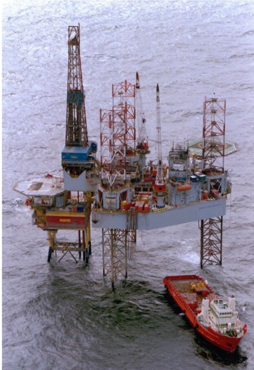
Figuur 5. Voorbeeld van een klein productieplatform (links) met boorplatform (rechts).
