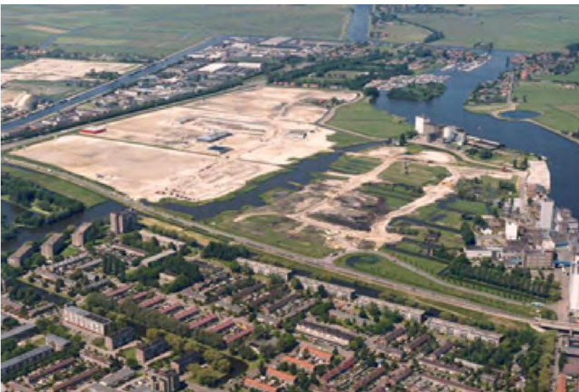
26. Links: het dempen van de sloten en bouwrijp maken van het plangebied voor de aanleg van bedrijventerrein Noorderveld; Bron: de site van Van Rossum B.V.
