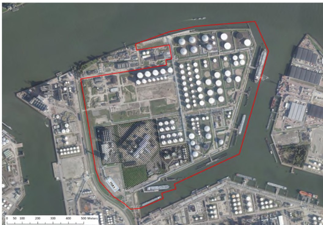
Figuur 4.7: Ligging Tank Truck Loading Rack 1
