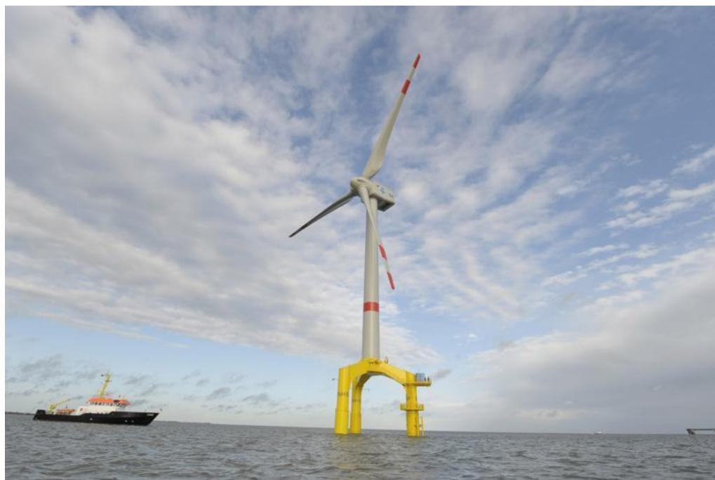
Figuur 2.5 Voorbeeld van een tripile fundatie 2 .
