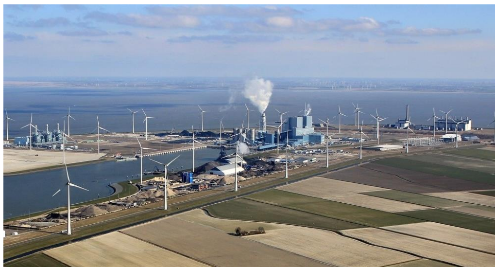
Figuur 2.2 Foto huidige situatie industrieterrein Eemshaven
