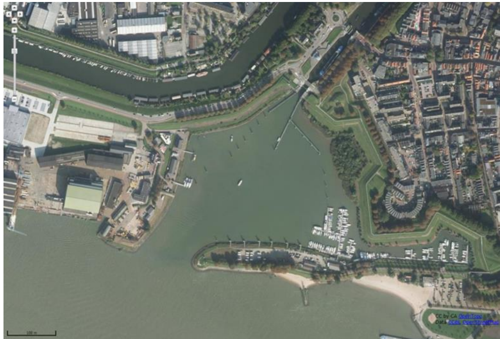
Figuur 2-4 Luchtfoto van de Vluchthaven Gorinchem
