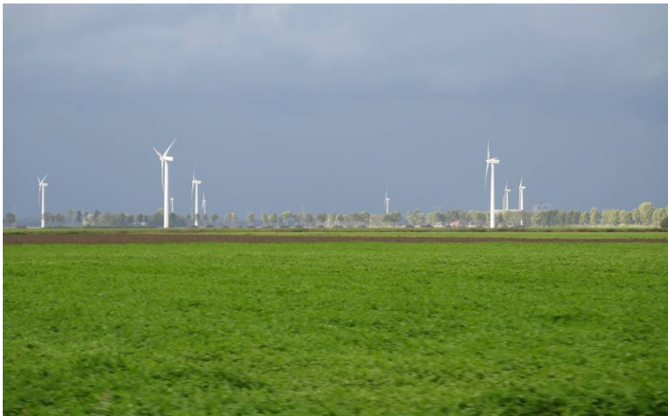
Figuur 5.14: Bestaande turbines tussen Lelystad en Dronten
