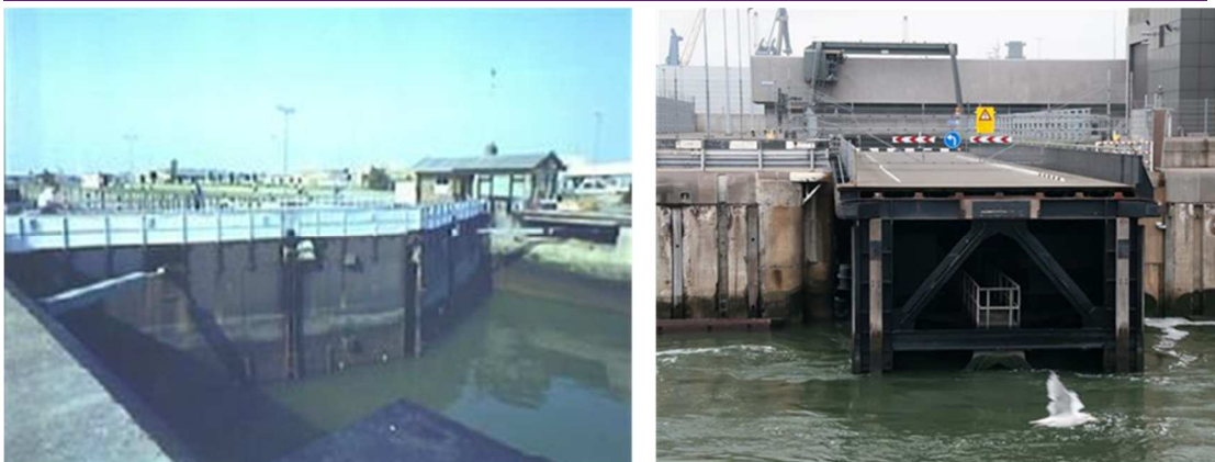
Figuur 3.2 Voorbeeld dynamische keermiddel met puntdeuren (links, zeewering Vlissingen) en met een roldeur (rechts, Noordersluis IJmuiden) Bron: Rijkswaterstaat, https://beeldbank.rws.nl .
