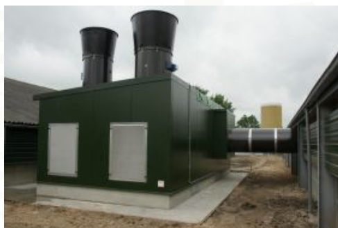
Foto 3 & 4: warmtewisselaar (situatie Buijs: 1 emissiepunt per wisselaar)
