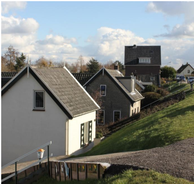
Afbeelding 2.3 Woningen onderaan en in de steile taluds van de dijk
