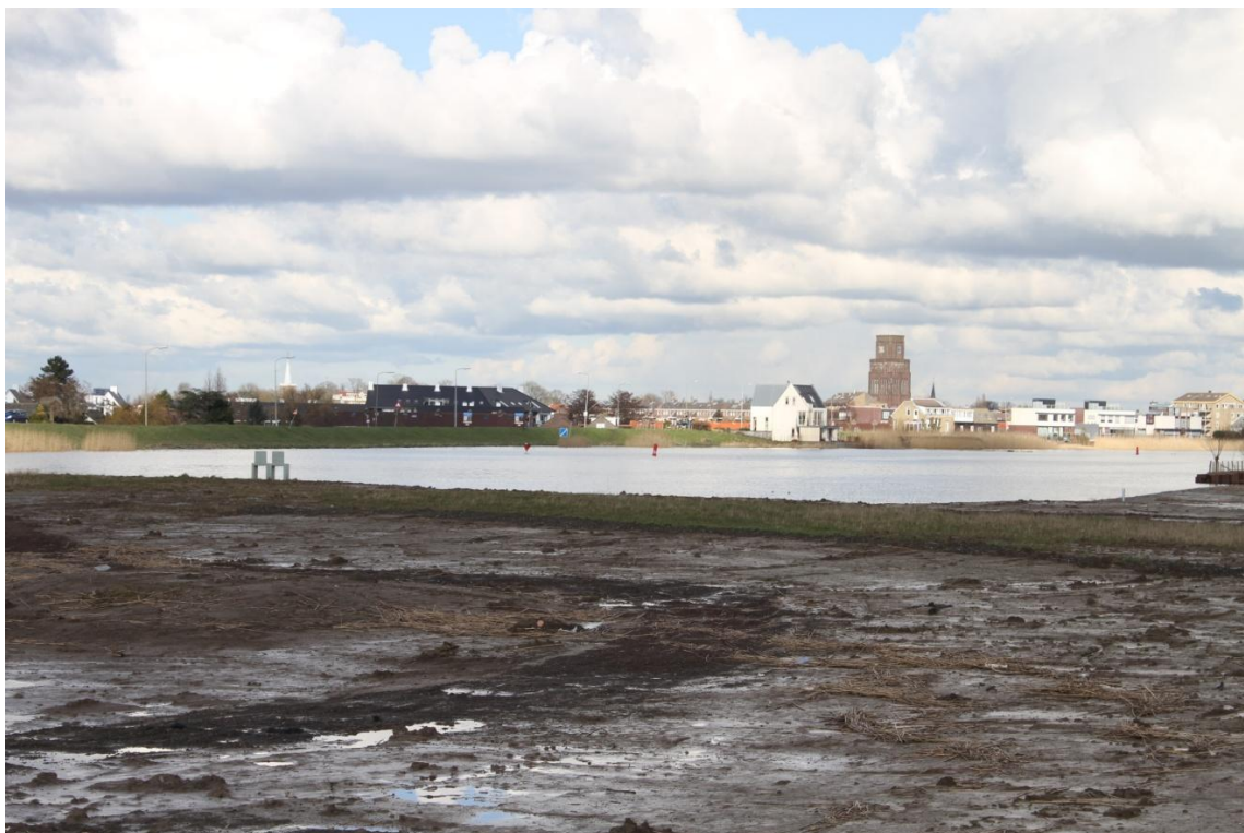
Afbeelding 2.12 Uitgevoerde saneringen in het voorland (of zelling)
