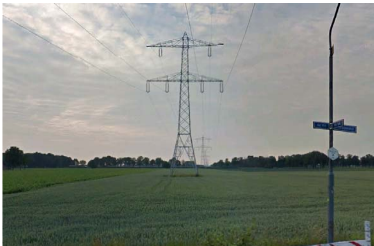
Hoogspanningsverbinding Boekel (bron: Google Streetview)
