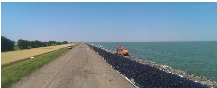
Figuur 9: Aanleg gepenetreerd breuksteen bij de Wieringermeerdijk
