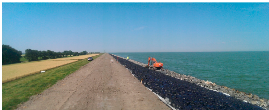
Figuur 17 Aanleg gepenetreerd breuksteen bij de Wieringermeerdijk
