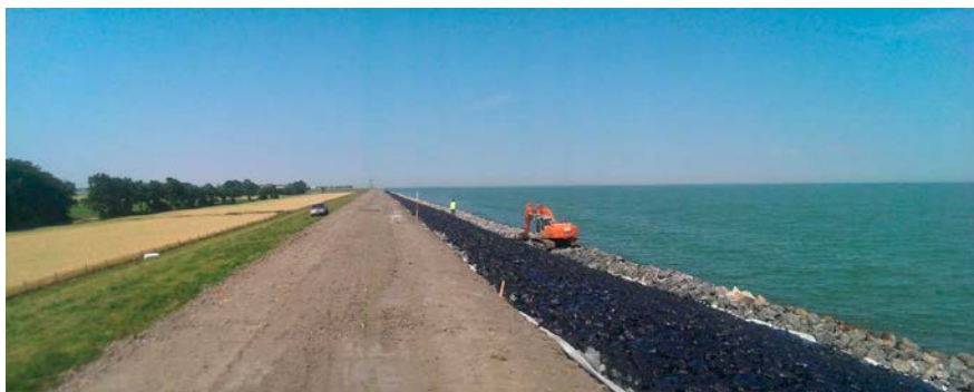
Figuur 15: Aanleg gepenetreerd breuksteen bij de Wieringermeerdijk
