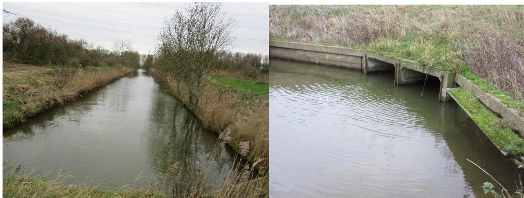
Figuur 7.15: Zijslot van de Lage Vaart richting en haaks op de A6, en de aanwezige duikers onder de A6 door.
