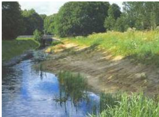
Waterloop met flauw talud
