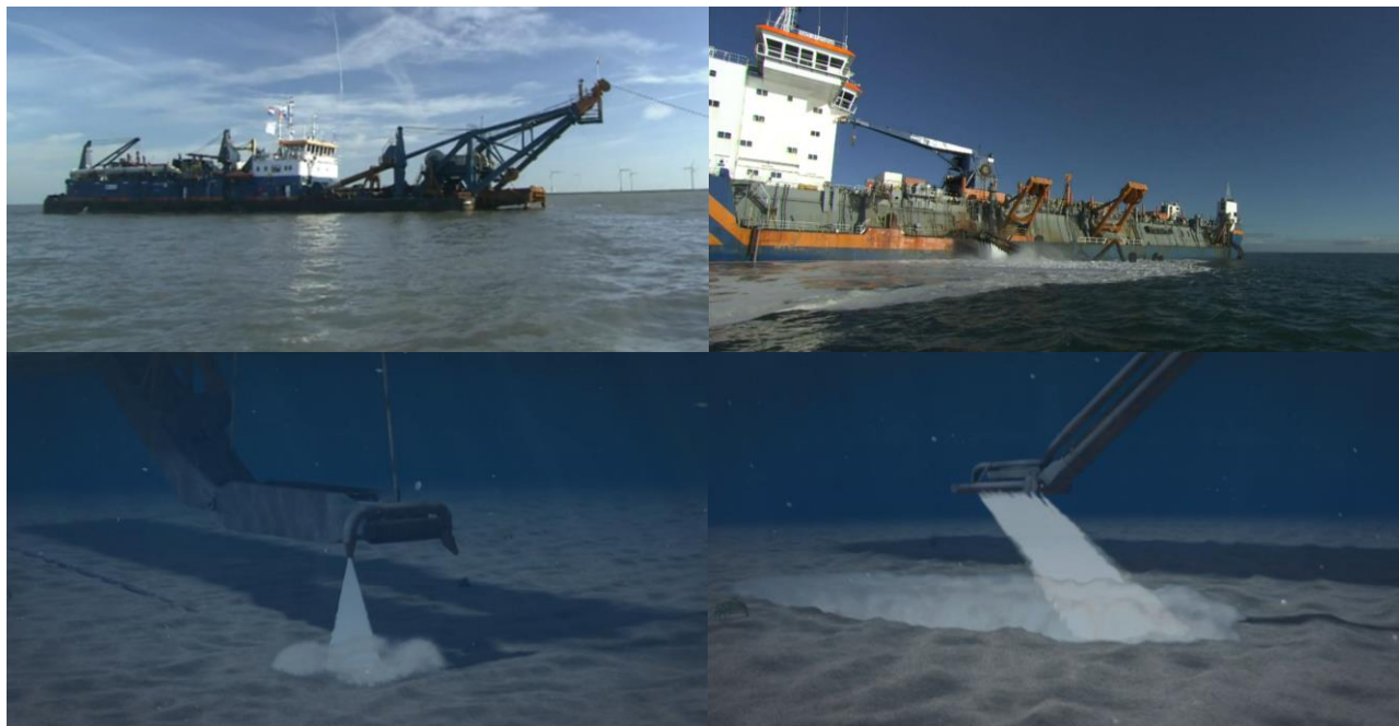
Figuur 7 Mass Flow Excavation zoals toegepast door van Oord om de NorNed kabel te herbegraven
