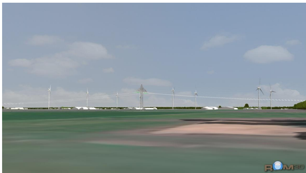
Figuur 4.7 Het windpark op minimale ashoogte van 100 14 meter, gezien vanaf de zuidzijde van Dedemsvaart, net ten oosten van de kruising Oostwijk/De Veenderij (kijkend naar het zuiden)
