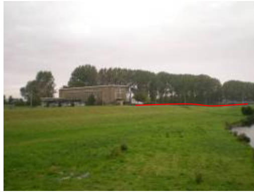
Het gemaal en de dijk gezien vanaf de Schielands Hoge Zeedijk
