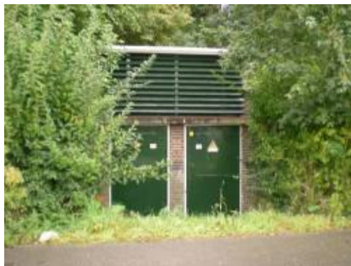
Trafogebouwtje in directe omgeving van watertoren
