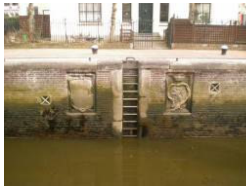
Twee gevelstenen in sluismuur
