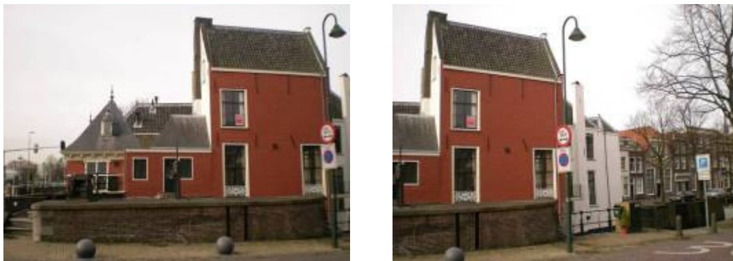
Tolhuis met de Havensluis ervoor – gezien vanuit oosten
