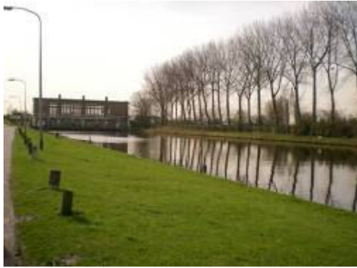
Stroomkanaal met uitzicht op het gemaal
