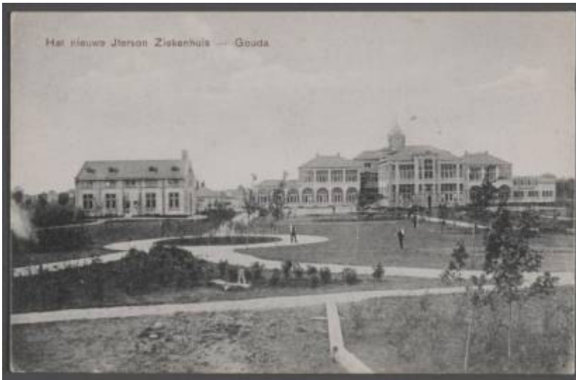
De achterkant van het nieuwe Van Iterson ziekenhuis aan De la Reylaan tijdens de aanleg van de tuin, gezien vanaf de Goejanvervelledijk. c. 1910. 70
