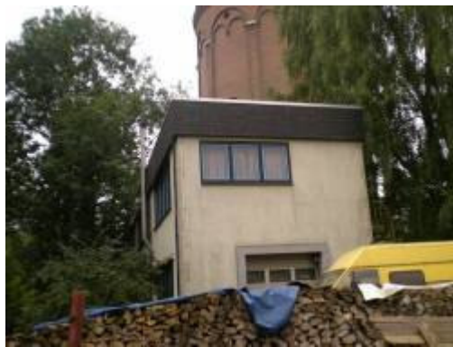
Latere uitbreiding aan watertoren
