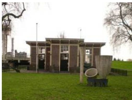
Schipperswachtlokaal of IJsselhuis
