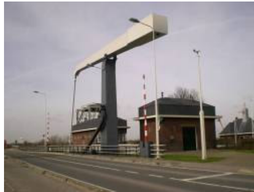
Detail brug met rechts de sluiswachterswoning
