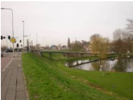
Foto genomen in westelijke kijkrichting met op de voorgrond het wiel en de betonnen brug.
