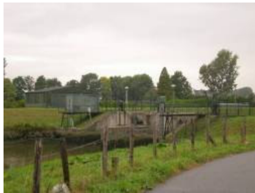
Waterkerend kunstwerk met zicht op opslaghuisje voor schotbalken
