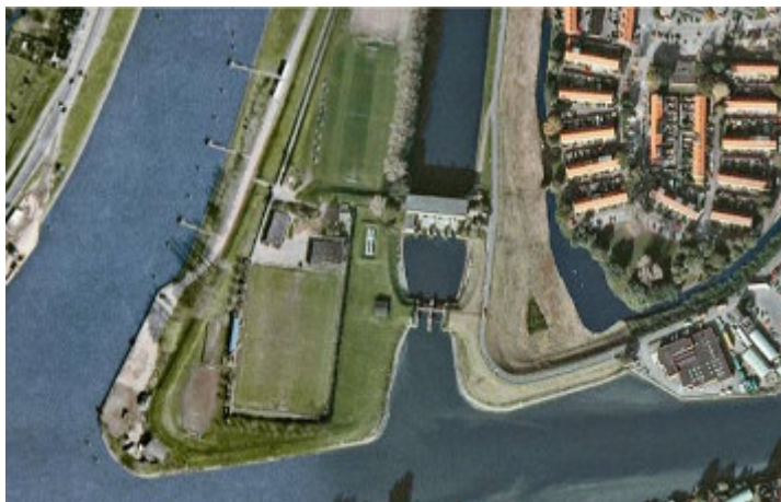
Luchtfoto 145 met sluiseland, het waterkerende kunstwerk en opslaghuisje voor schotbalken
