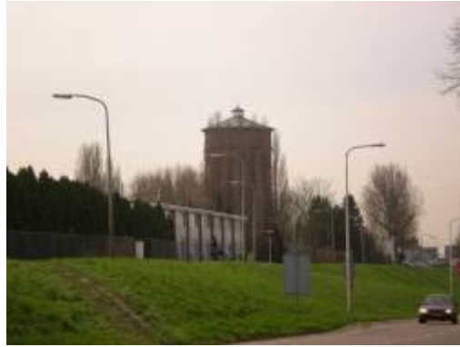
Watertoren gezien vanaf Rotterdamseweg
