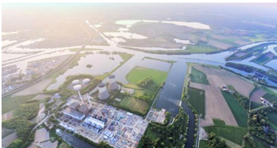
Figuur 21 | Zicht op de Clauscentrale in huidige vorm vanuit de lucht ( http://www.essent.nl/content/overessent/actueel/werkinuitvoering/modernisering_clauscentrale/index.html )
