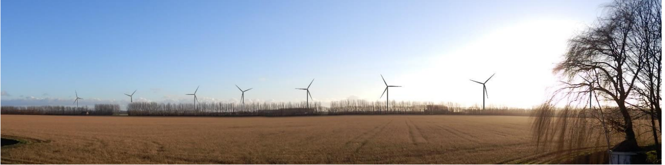
Foto-inpassing 1: windpark Hoge Zandse Polder gezien vanaf Schuringsdijk
