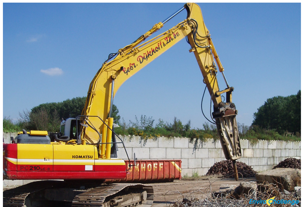
Illustratie 2 : Verkleining van grof puin met pneumatische hamer
