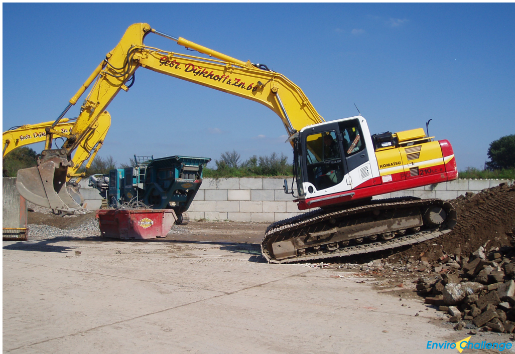
Illustratie 3 : Van opslag rijdende rups mobiele graafmachine
