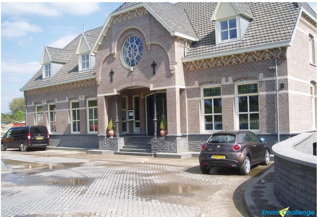
Illustratie 3 : Gebouw met kantoor (rechts) en werkplaats (links) anno 2014
