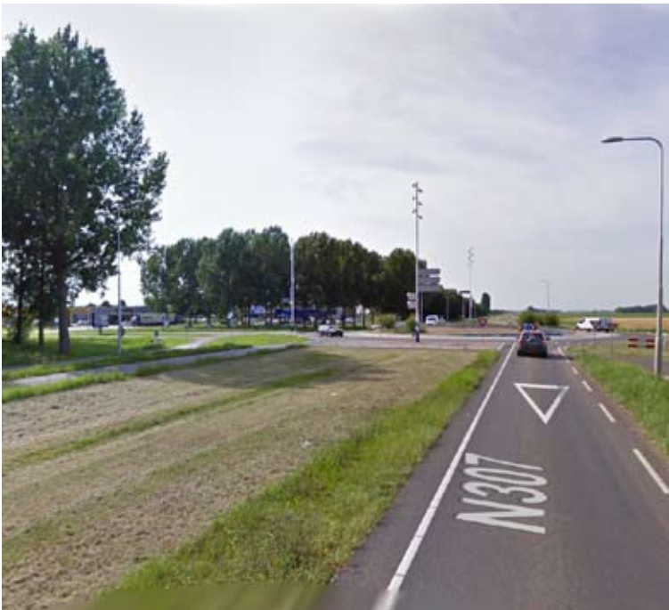
Bestaande situatie rotonde De Noord
