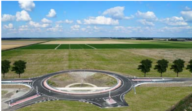
Situatie rotonde Overijsselseweg bij de Poort van Dronten
