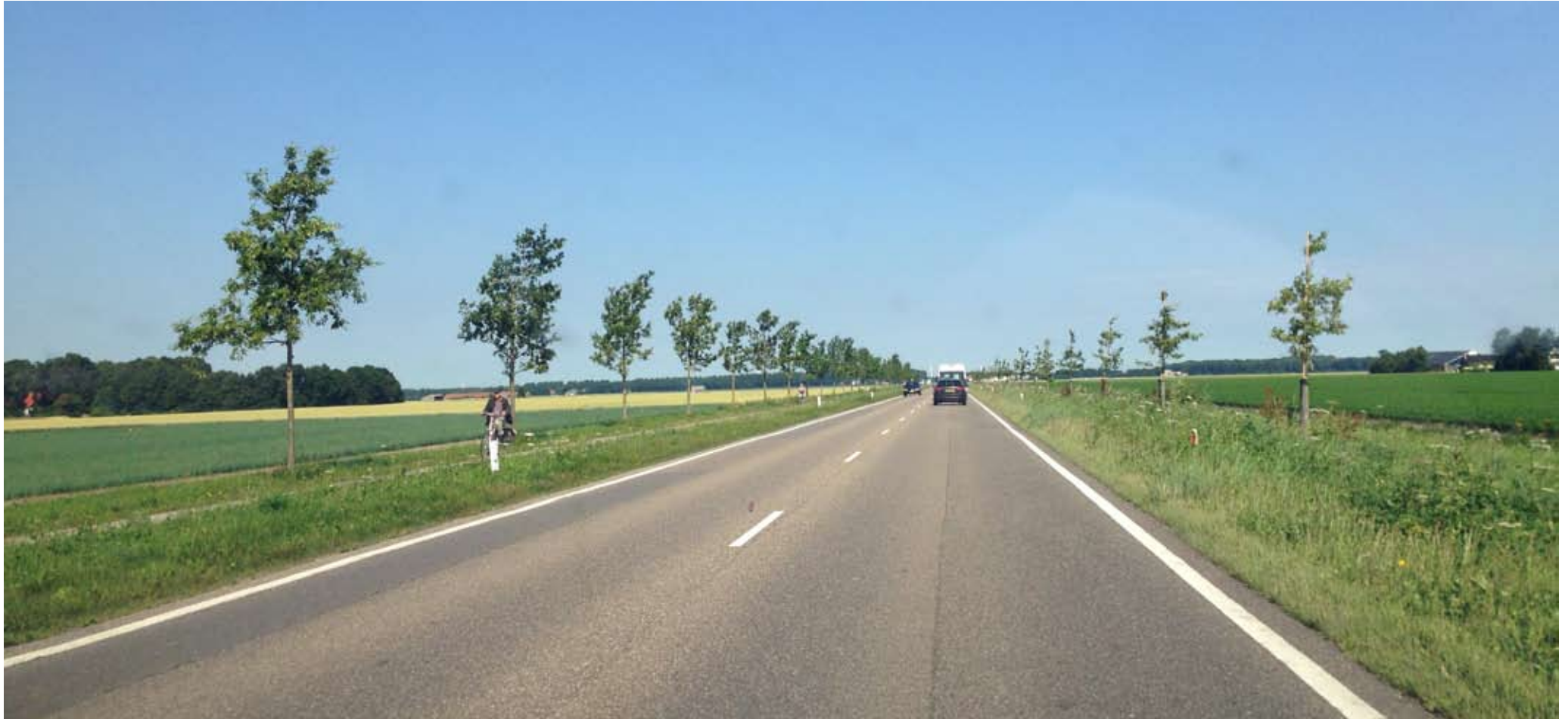
Recentelijk vernieuwde bomenlaan langs de Dronerringweg richting Swifterbant als voorbeeld voor de Dronerringweg t.h.v. Dronten
