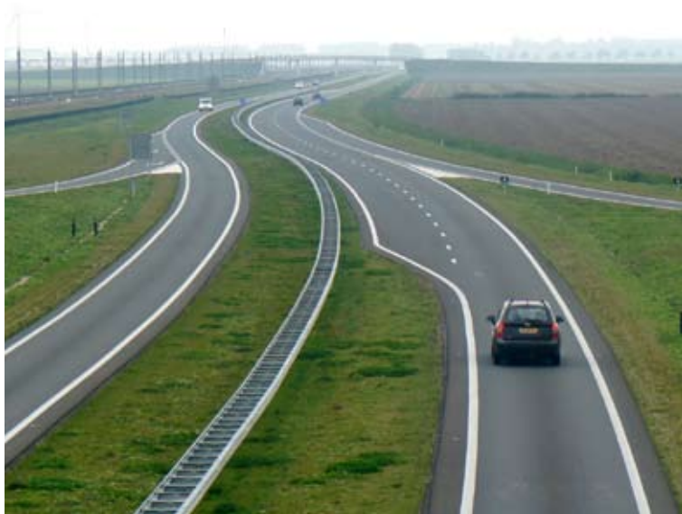
N307 Overijsselseweg Dronten richting Lelystad
