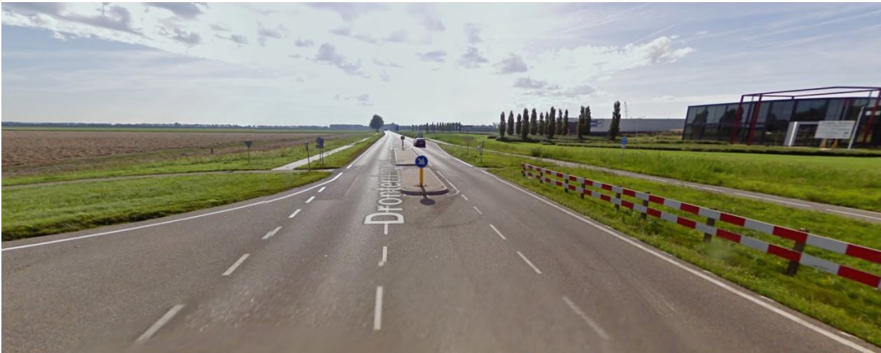
figuur 9.1 Huidige situatie plangebied N307 Passage Dronten
