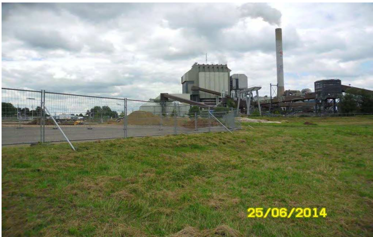
Onderzoekslocatie, richting omheinde parkeerterrein
