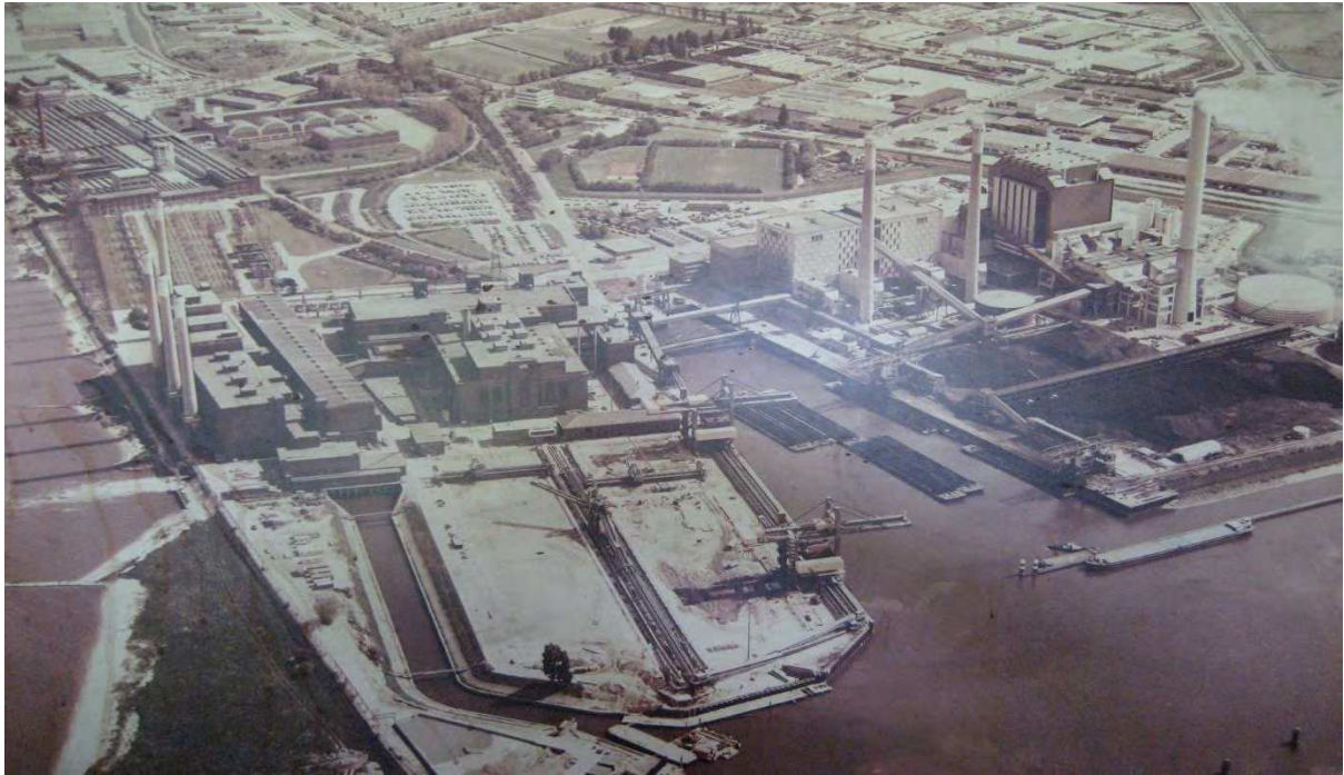
Boven: Overzichtsfoto van de energiecentrale Gelderland met links van de havenarm, het noordelijk terreindeel met midden op foto centrale CG1. Rechts van de havenarm is het terrein van de huidige energiecentrale zichtbaar met de voormalige gebouwen CG11 en CG12 en centrale CG13..
