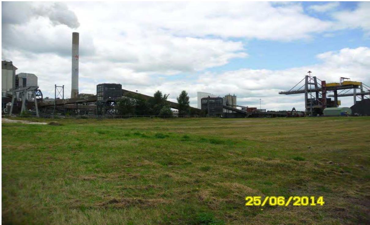
Situatie maaiveld, het maaiveld van het sloopterrein van het vroegere centralegebouw CG 1 is circa 2 meter verlaagd ten opzichte van de omgeving
