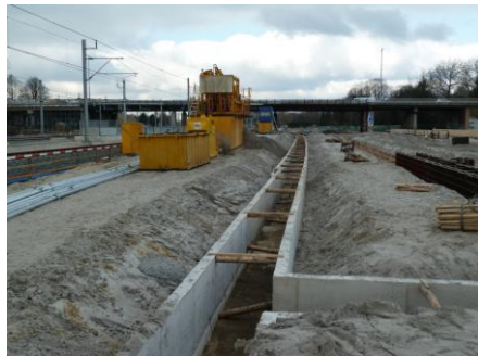
Geleidewandjes langs diepwandsleuf
