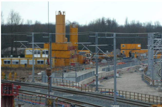
Materieelpark voor het maken van diepwanden
