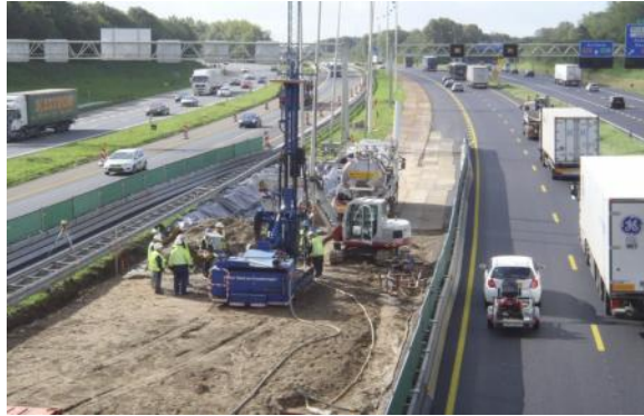
Jetgrouten in de middenberm van de A27
