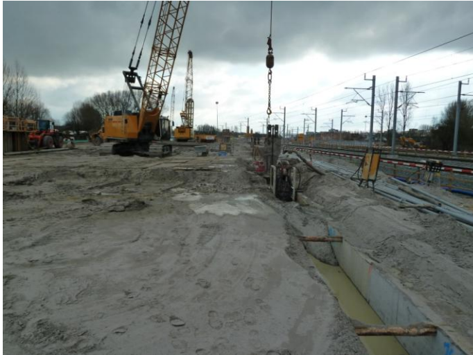
Ontgraven van de diepwandsleuf
