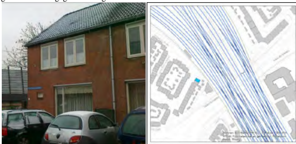
Figuur 4-8 Gevel J.J.A. Gouverneurstraat 47 (figuur links) en sporenlay-out ten tijde van de metingen (figuur rechts)
