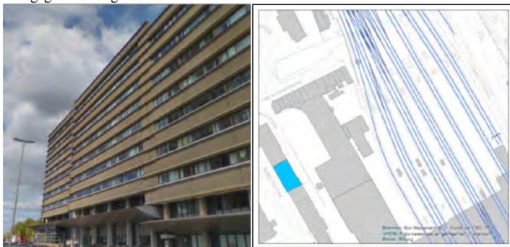
Figuur 4-11 Gevel Jaarbeursplein 22 (figuur links) en sporenlay-out ten tijde van de metingen (figuur rechts)
