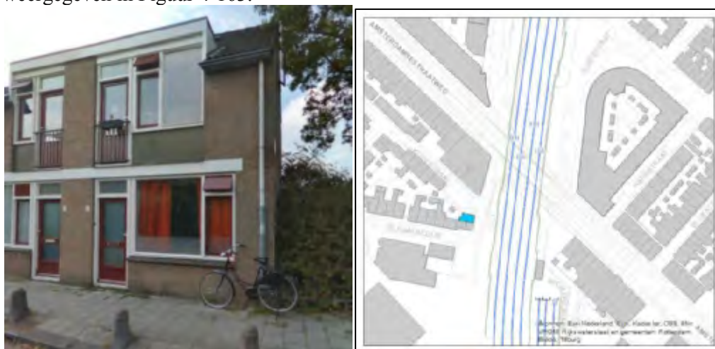
Figuur 4-163 Gevel Dijkstraat 20 (figuur links) en sporenlay-out ten tijde van de metingen (figuur rechts)
