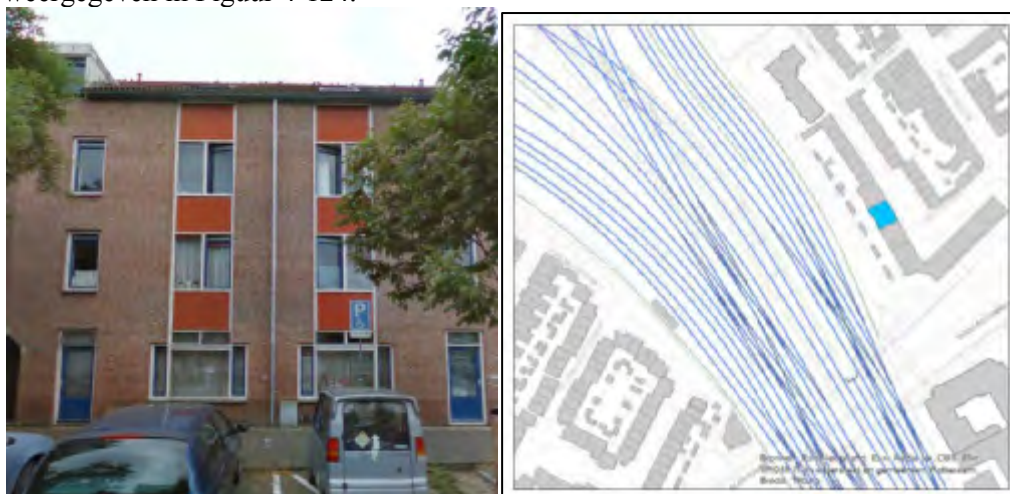
Figuur 4-124 Gevel Wolfstraat 100 (figuur links) en sporenlay-out ten tijde van de metingen (figuur rechts)
