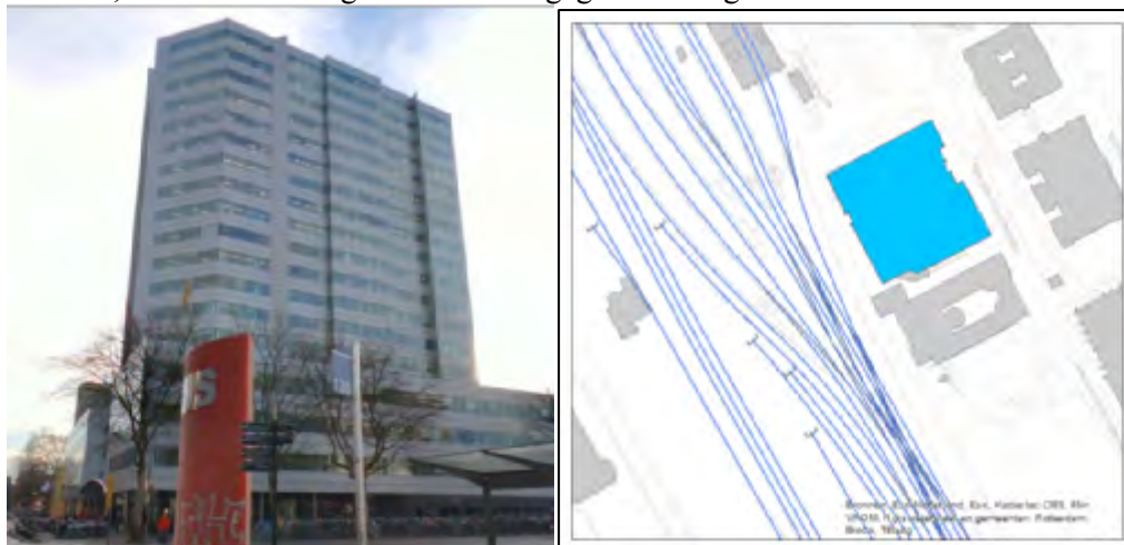
Figuur 4-112 Gevel Laan van Puntenburg 100 (figuur links) en sporenlay-out ten tijde van de metingen (figuur rechts)
