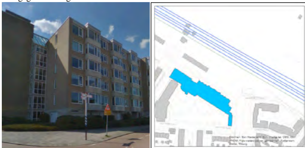
Figuur 4-36 Gevel Saffierlaan 10-770 (appartement op vijfde verdieping, figuur links) en sporenlay-out ten tijde van de metingen (figuur rechts)
