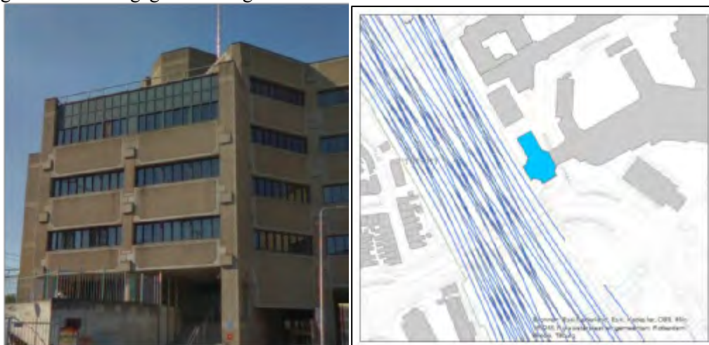
Figuur 4-118 Gevel Leidseveer 10 (figuur links) en sporenlay-out ten tijde van de metingen (figuur rechts)
