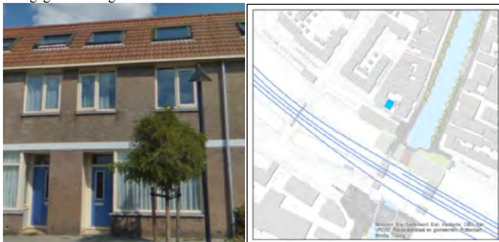
Figuur 4-94 Gevel Vaartsestraat 176 (figuur links) en sporenlay-out ten tijde van de metingen (figuur rechts)
