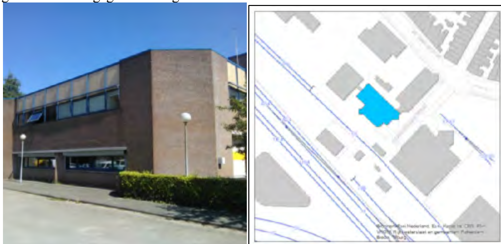
Figuur 4-166 Gevel Concordiastraat 67 (figuur links) en sporenlay-out ten tijde van de metingen (figuur rechts)
