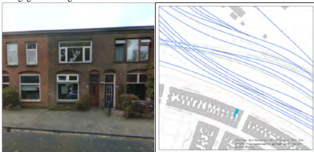
Figuur 4-2 Gevel Cremerstraat 96 (figuur links) en sporenlay-out ten tijde van de metingen (figuur rechts)
