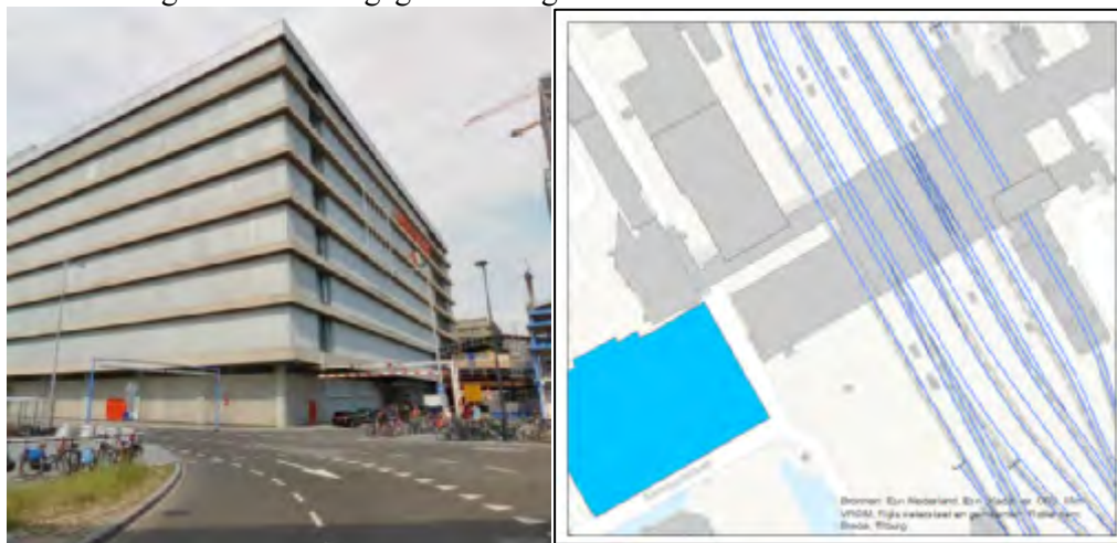
Figuur 4-17 Gevel Jaarbeursplein 6 (figuur links) en sporenlay-out ten tijde van de metingen (figuur rechts)
