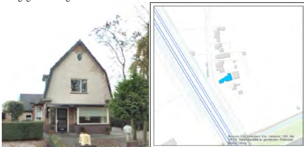
Figuur 4-67 Gevel Mereveldseweg 15 (figuur links) en sporenlay-out ten tijde van de metingen (figuur rechts)
