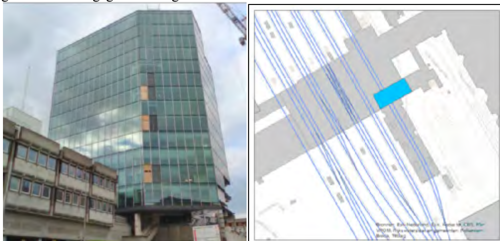
Figuur 4-115 Gevel Katreinetoren (figuur links) en sporenlay-out ten tijde van de metingen (figuur rechts)
