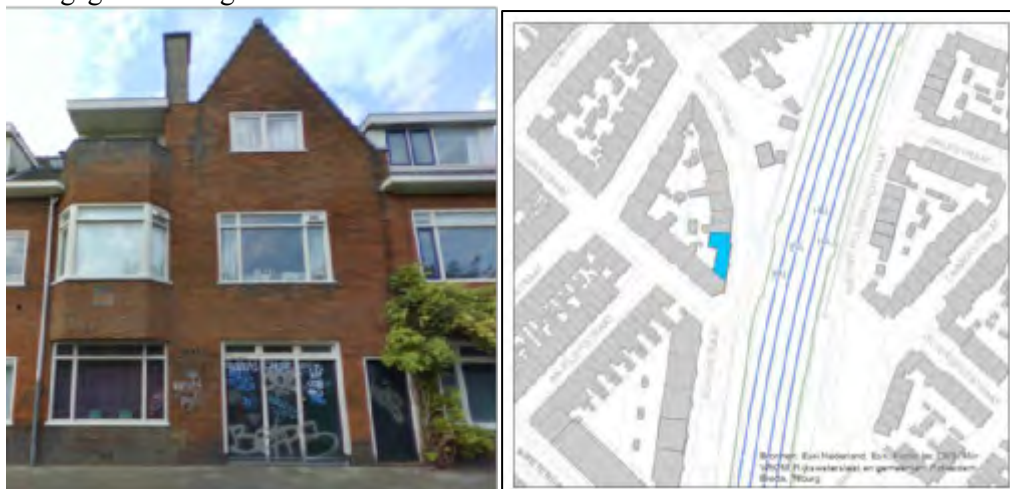
Figuur 4-154 Gevel Schutstraat 64 (figuur links) en sporenlay-out ten tijde van de metingen (figuur rechts)
