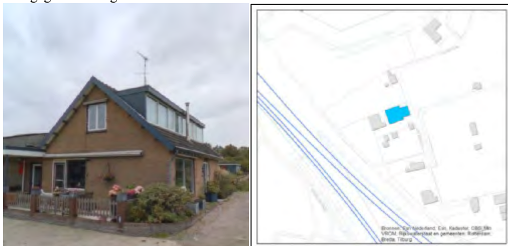
Figuur 4-79 Gevel Rijndijk 23 (middelste woning, met blauwgrijze dakpannen, figuur links) en sporenlay-out ten tijde van de metingen (figuur rechts)
