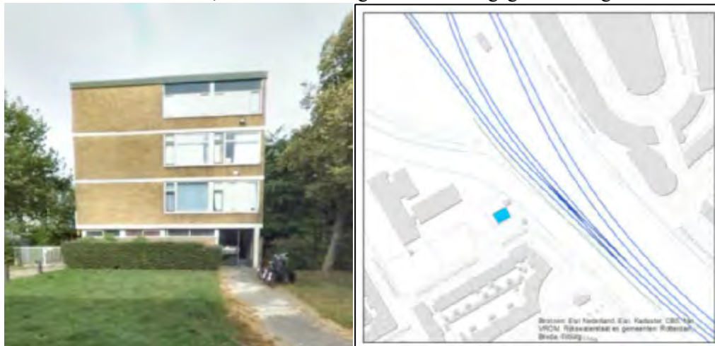
Figuur 4-20 Gevel Hendrik Tollenstraat 1 (onderste appartement) en 5 (bovenste appartement, figuur links) en sporenlay-out ten tijde van de metingen (figuur rechts)
