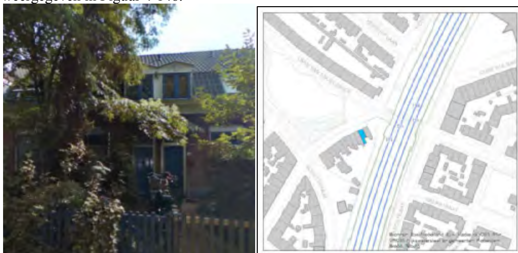
Figuur 4-148 Gevel Leliestraat 55 (figuur links) en sporenlay-out ten tijde van de metingen (figuur rechts)
