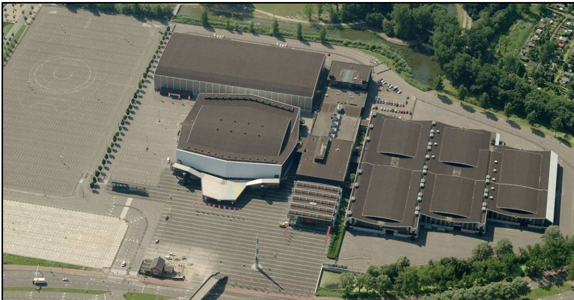
Afbeelding 4.5: Het Ahoycomplex, met linksonder het rioolgemaal.
