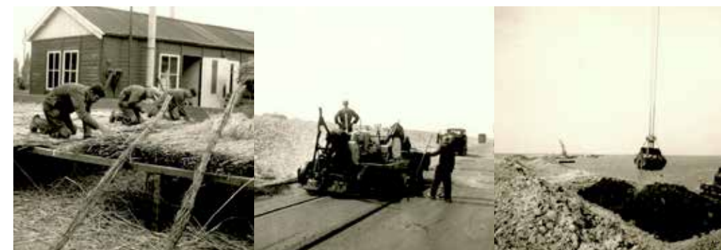
Figuur 3.1 Aanleg van de Houtribdijk (foto's Edzo H. Ebbens)
