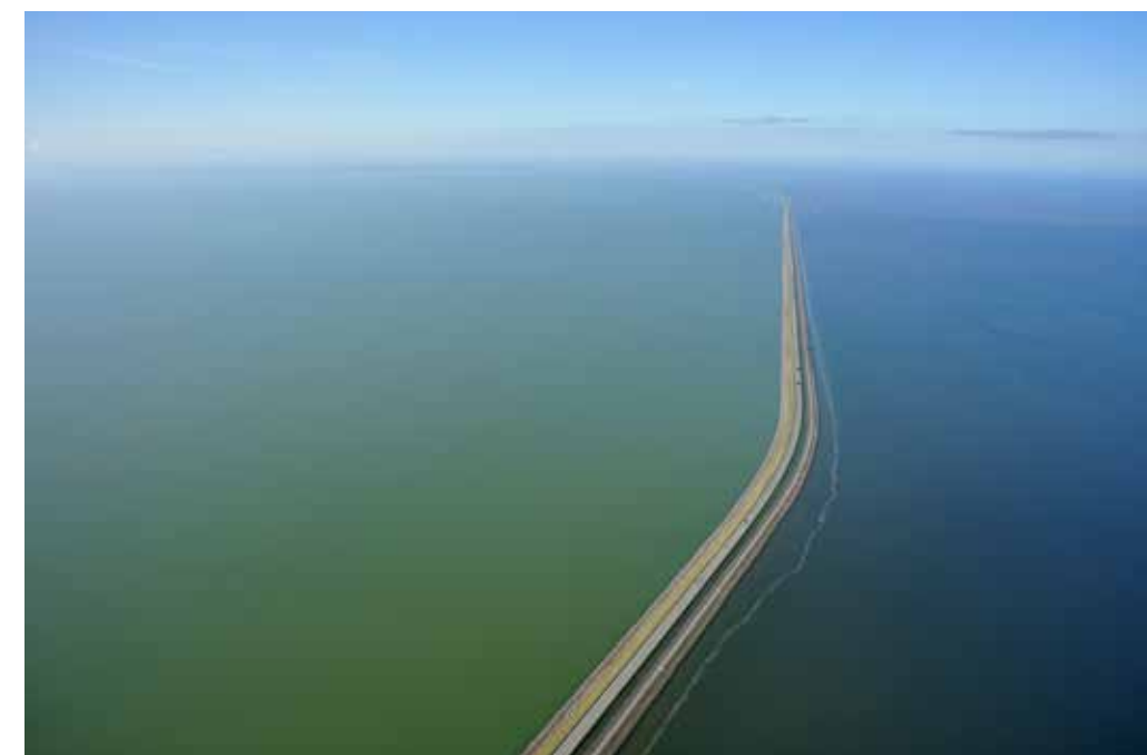
Figuur 1.1 Houtribdijk vanuit de lucht
