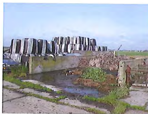
Foto 4: sleufsilo's achter de stal
