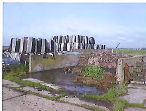
Foto 4: sleufsilo's achter de stal
