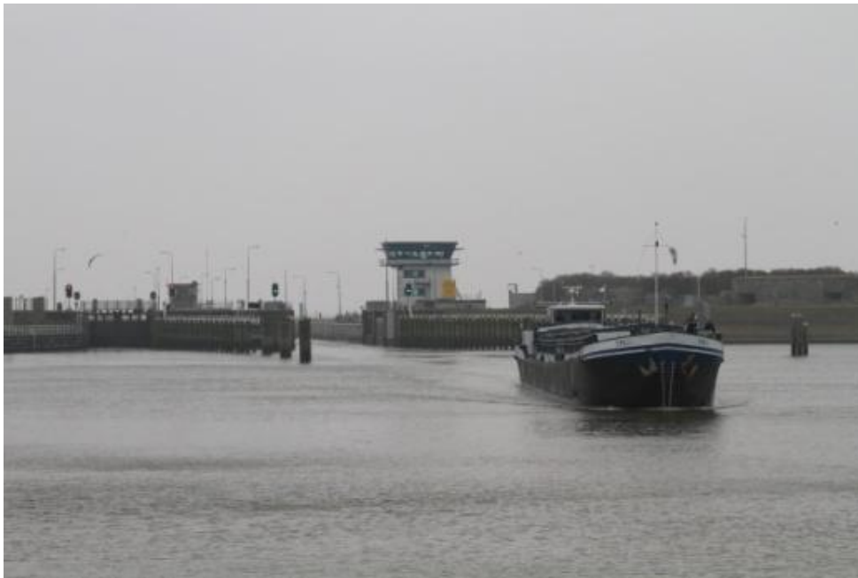
Figuur 2.3. Schutsluizen Kornwerderzand (Lorentzsluizen).
