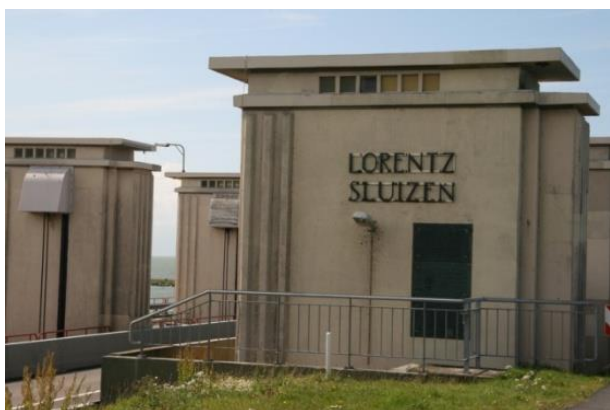
Figuur 1-2: Lorentz sluizen bij Kornwerderzand
