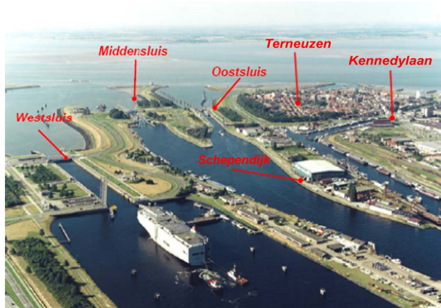
Figuur 2.2 Overzicht Sluisencomplex Terneuzen
