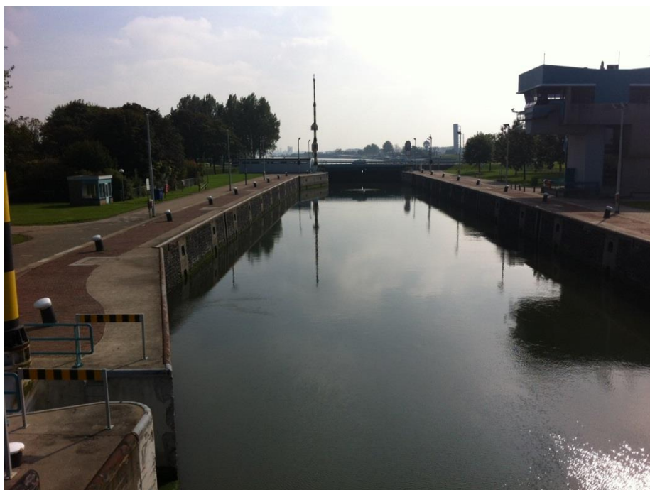
Figuur 6.4 Middensluis sluizencomplex Terneuzen
