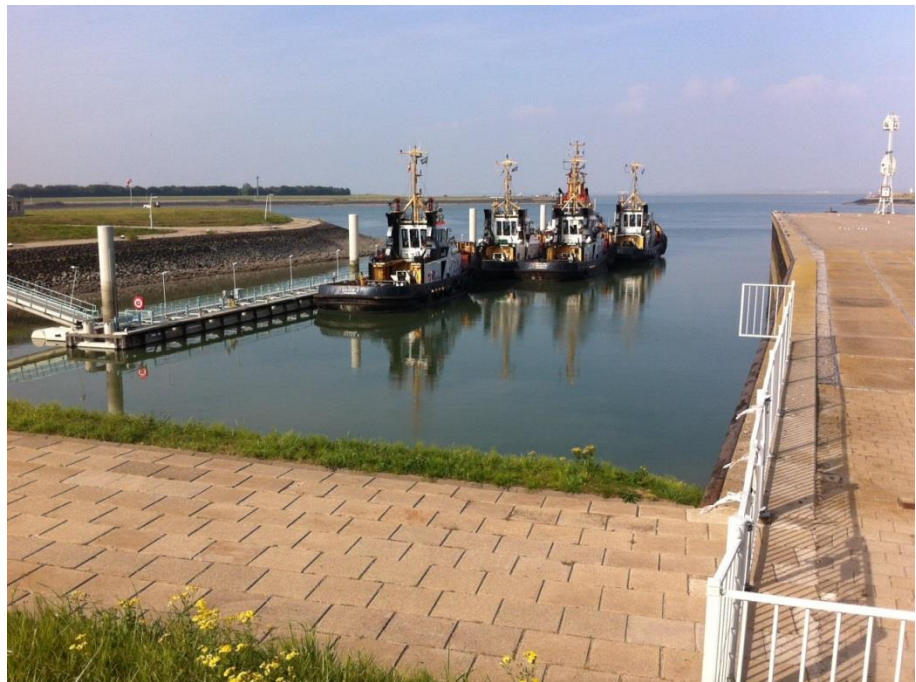
Figuur 2.3 Sleepboten in de haven op het sluisencomplex
