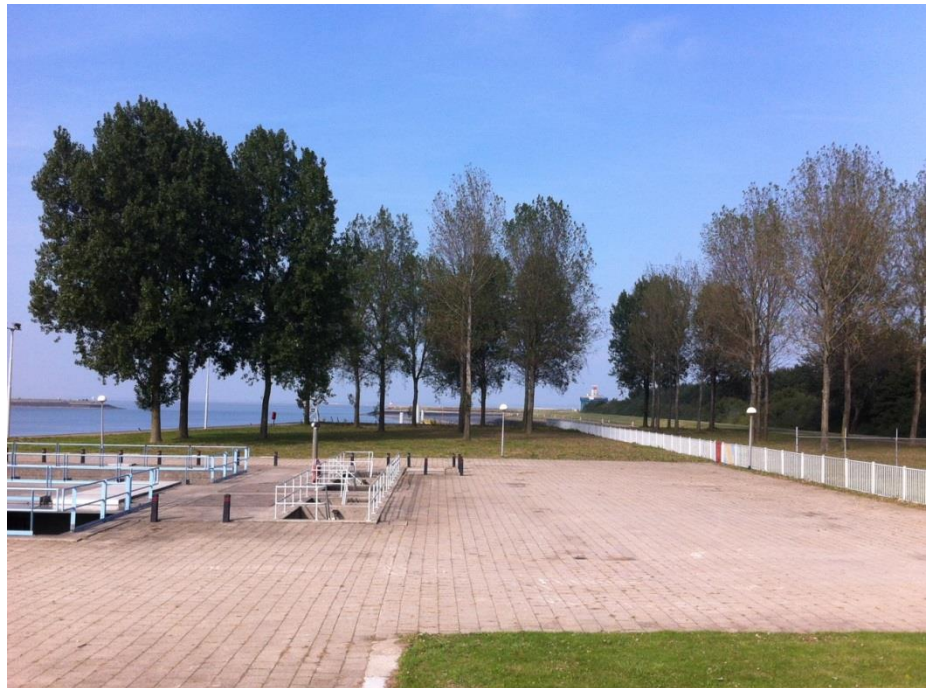
Figuur 3.3 Foto van het sluisencomplex
