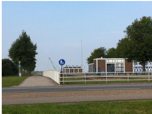
Figuur 3.1 Sluizencomplex Terneuzen
