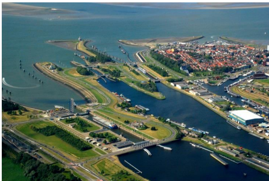
Figuur 3.2 overzicht sluizencomplex Terneuzen
