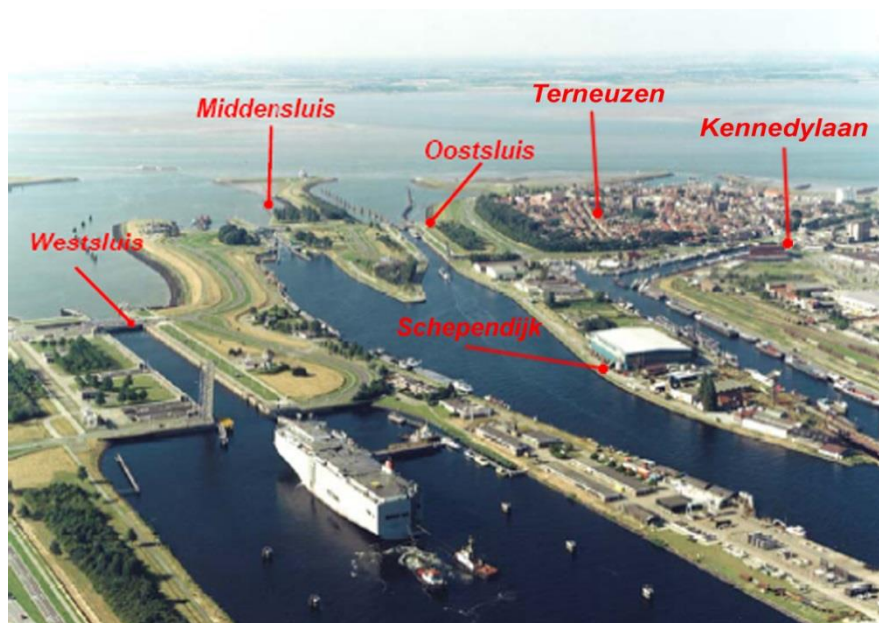
Figuur 2.2 Overzicht Sluisencomplex Terneuzen
