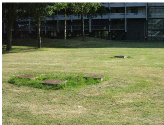
Foto 1 Enkele boven het maaiveld uitstekende rioolinspectieputten (rechter foto licht net buiten het nu te beschouwen plangebied)
