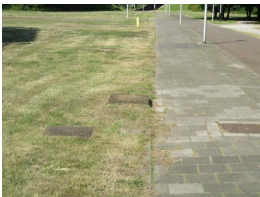
Foto 1 Enkele boven het maaiveld uitstekende rioolinspectieputten (rechter foto licht net buiten het nu te beschouwen plangebied)
