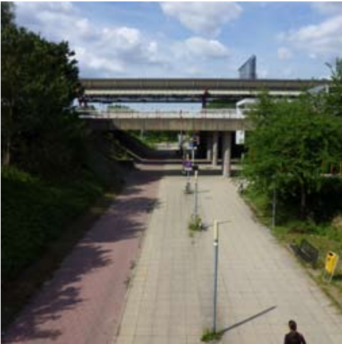
spoorweginfrastructuur aan de rand
