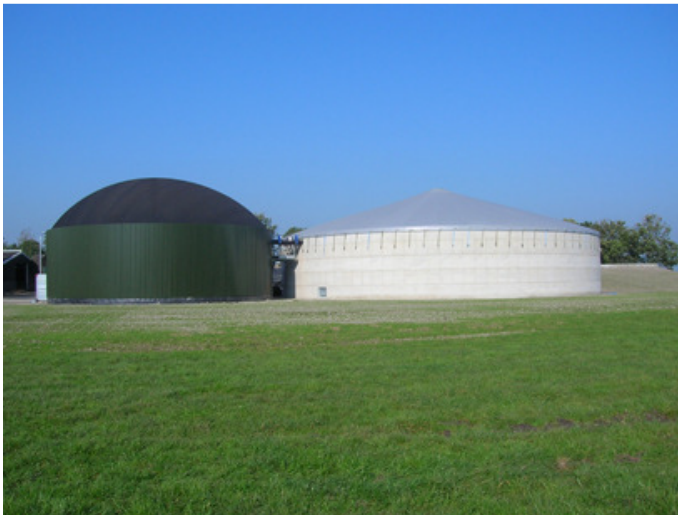
Figuur 10. Vergister en navergister op boerderijschaal
