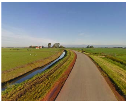
Figuur 48. Smal wegprofiel langs de Hesenserreed
