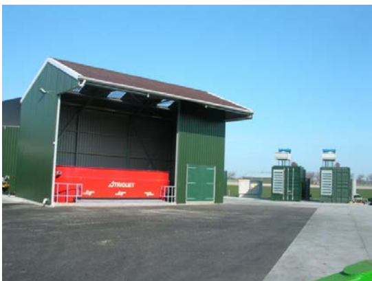
Figuur 11. Technische ruimte met daarnaast twee WKK-installaties
