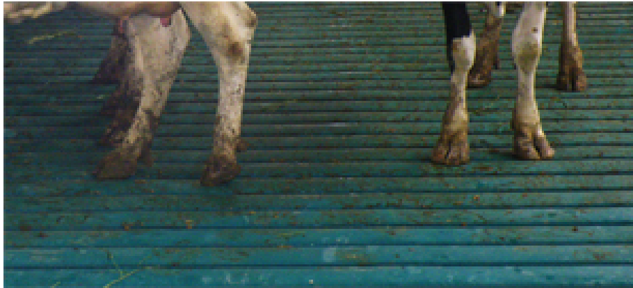
Figuur 7.1 Groene Vlag Roostervloer: emissiearm stalsysteem voor melkveehouderijen
