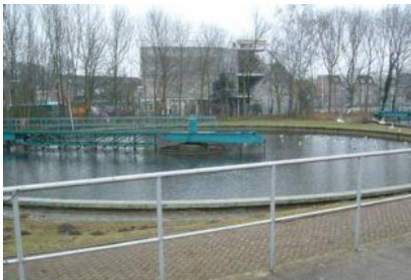
Figuur 5.5: Eén van de bezinktanks RWZI Utrecht
