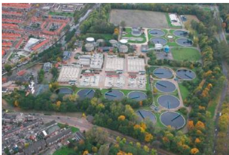
Figuur 5.4: Luchtfoto RWZI vanaf oostzijde
