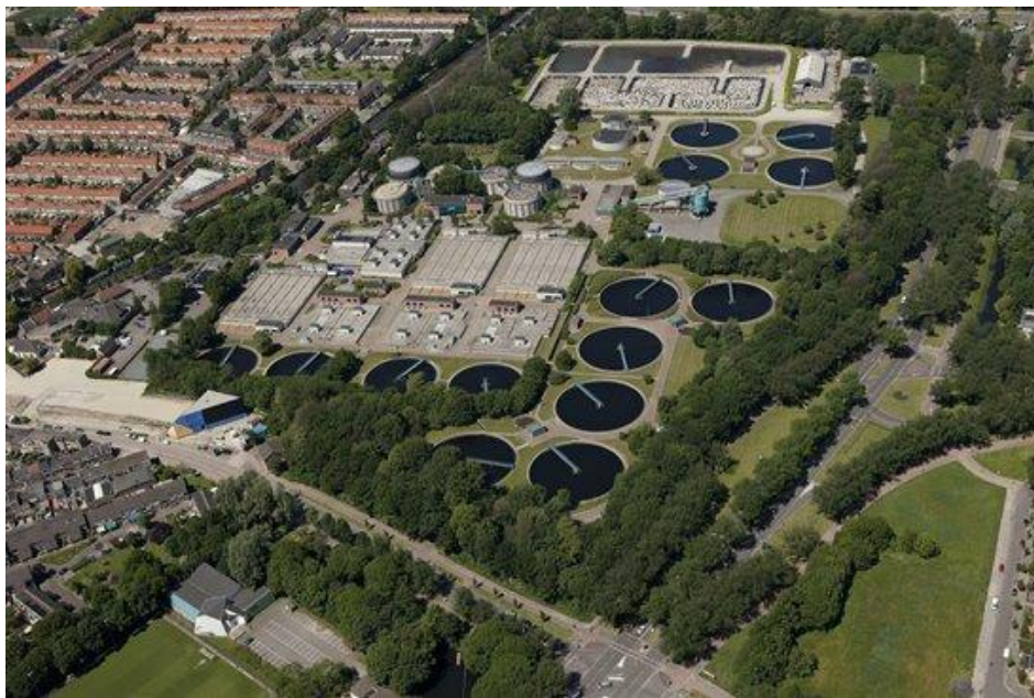
Figuur 5.1: Ligging rioolwaterzuivering met omliggende bebouwing (op deze foto zijn de inmiddels verwijderde slibvelden op de achtergrond te zien)
