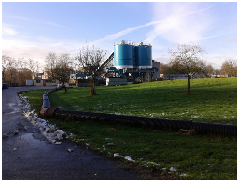
Figuur 6.1: Huidige slibvergistingsinstallatie
