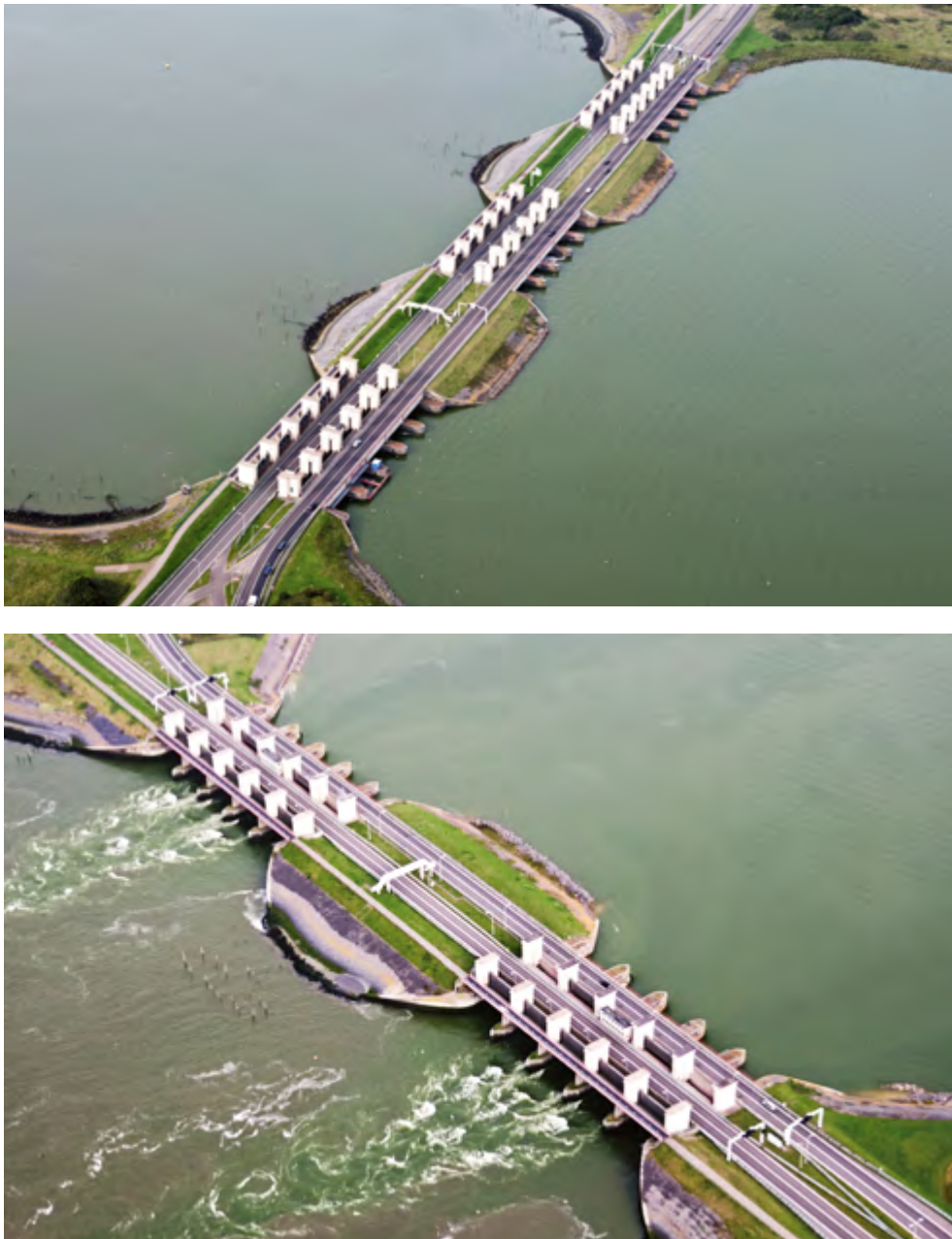
Afbeelding 3.5 Spuicomplex Den Oever en spuicomplex Kornwerderzand
