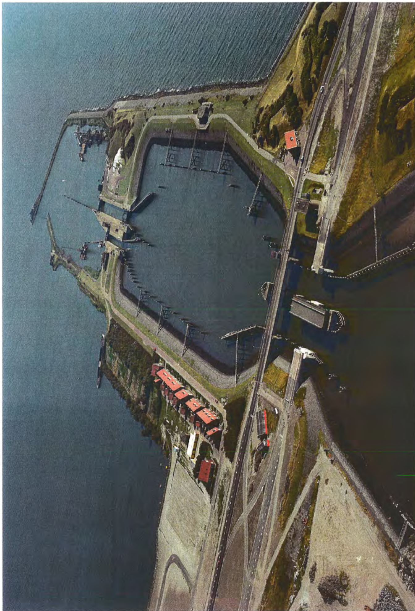
Afbeelding 4. Schutshuis, deel van de eerste linie met zicht op het IJsselmeer, 1974
