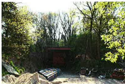
Foto 1.8 De oude te slopen loods
