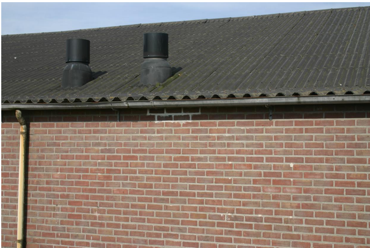
Figuur 3. Eén van de te slopen stallen vanaf de niet-binnenplaatszijde gezien
