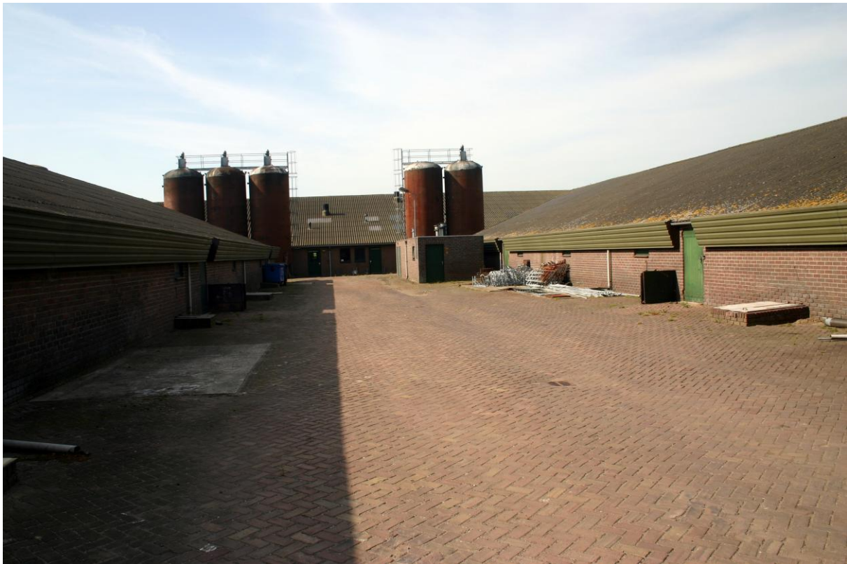
Figuur 2. De te slopen stallen, gezien vanaf de binnenplaatszijde
