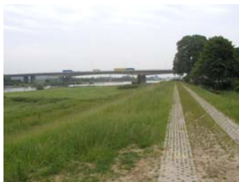
Brug van de A50.
