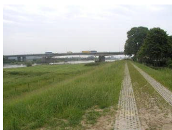
Brug van de A50
