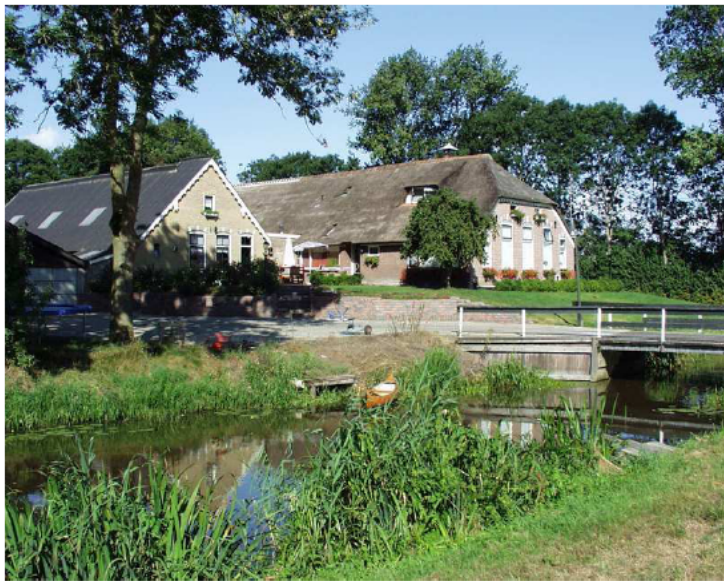
Brug als toegang naar het erf
