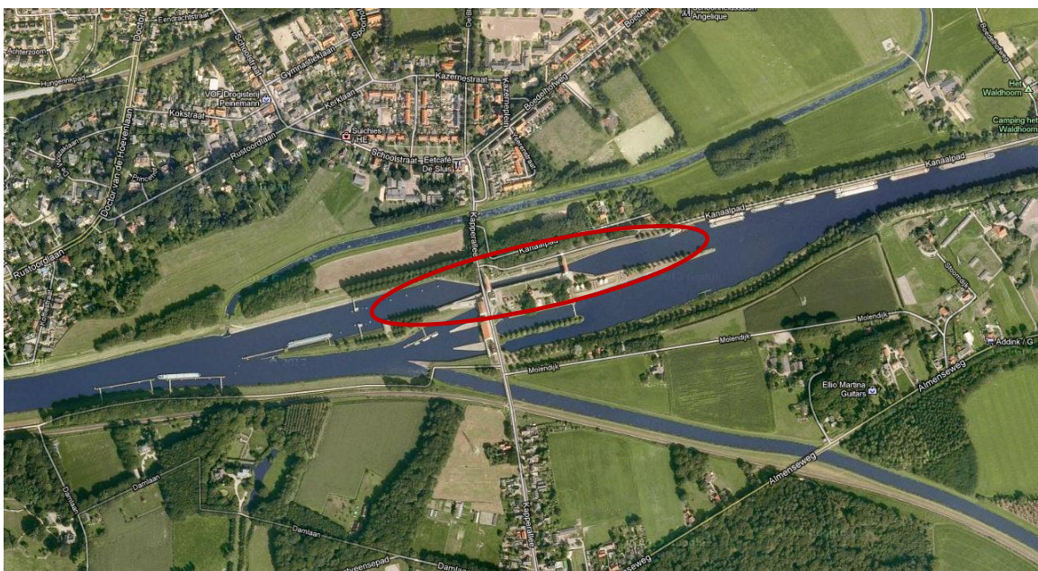
Figuur 9.1: Situering bestaande schutsluis
