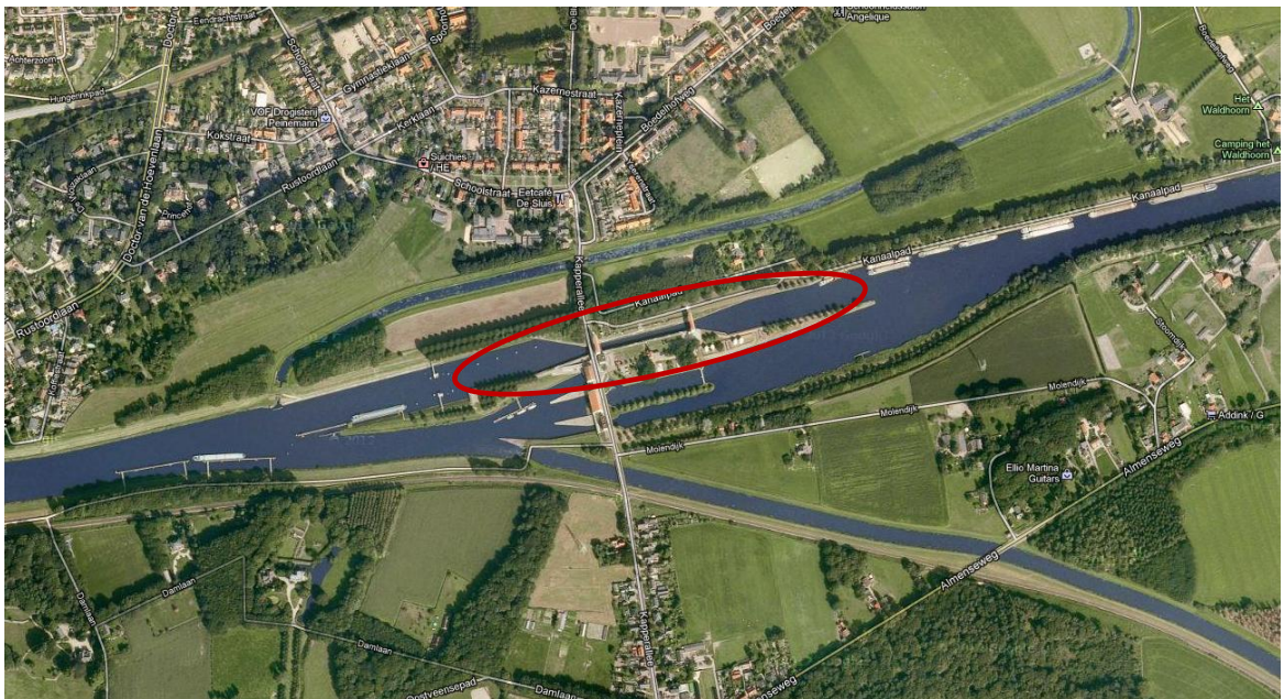
Figuur 1.1: Situering bestaande schutsluis
