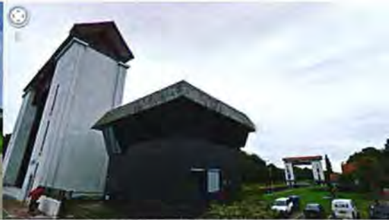
1-3: De Sluis, sluiswachterhuis en woning.
