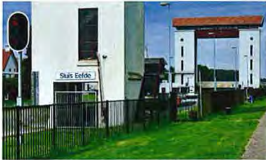
1-2: De sluis in oostwestelijke richting.
