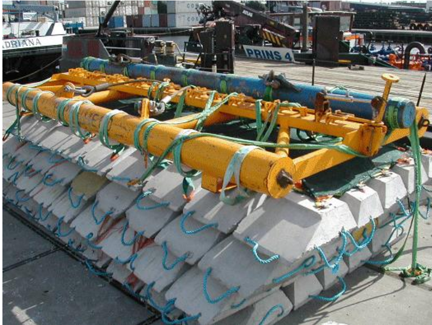
Figuur 3.7: Mat van steen dat gebruikt wordt voor kabelkruisingen (Noordzeewind, Offshore Windfarm Egmond aan Zee General report, 2008)
