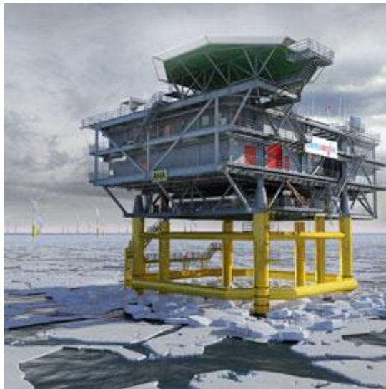
Figuur 2.5: Transformatorstation op een jacket bij Anholt, Denemarken
