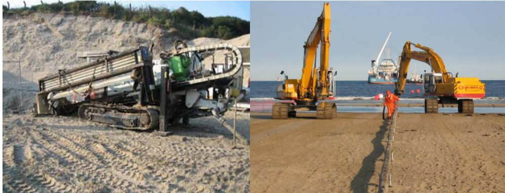
Figuur 3.8: Links een voorbeeld van een boorinstallatie om door de duinen te boren en rechts de kabel op het strand met op de achtergrond het schip dat de kabel richting windpark ingraaft (Noordzeewind, Offshore Windfarm Egmond aan Zee General report, 2008)
