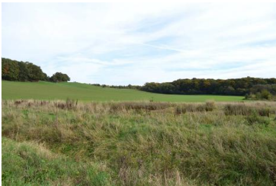
Figuur 1.3 Gebied verdiepte ligging Buitenring Parkstad Limburg (vanaf de Naanhofsweg in de richting van het tracé richting het noordoosten, rechts het Jeugrubbebos, links bos ten zuiden van Vaesrade)
