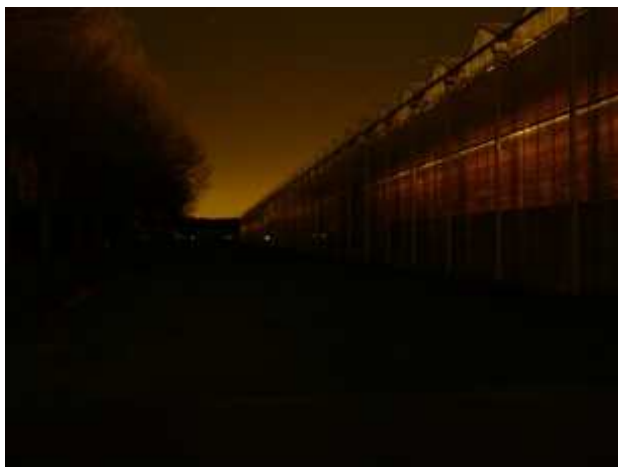
lichtemissie uit kas met bovenafscherming; bij de afgeschermd kas wordt de emissie van licht zover teruggedrongen dat de lichtvervuiling aan de horizon niet meer bepaald wordt door de kas.
